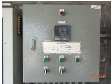
ภาพที่ 2.2-16 pH Meter แบบอัตโนมัติ บริเวณบ่อปรับสภาพกรด-ด่าง
