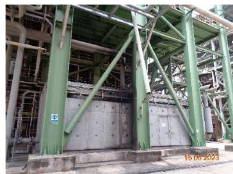
ภาพที่ 2.2-38 อุปกรณ์ลดเสียง Silencer และปิดครอบเครื่องจักรที่มีเสียงดัง
