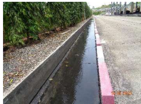
ภาพที่ 2.2-17 ร่องน้ำขนาดกว้าง 2 เมตร ลึก 1.5-2.2 เมตร ล้อมรอบกองถ่านหิน
