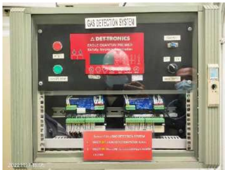
ภาพที่ 2.2-40 อุปกรณ์ตรวจสอบก๊าซไฮโดรคาร์บอน
