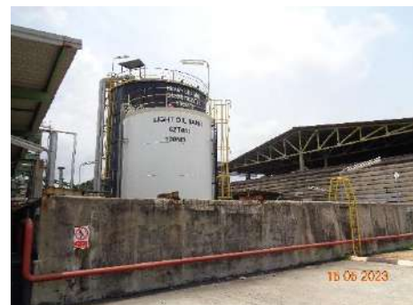
ภาพที่ 2.2-13 Dike สำหรับกักเก็บสารเคมีและถังสำรองเชื้อเพลิง
