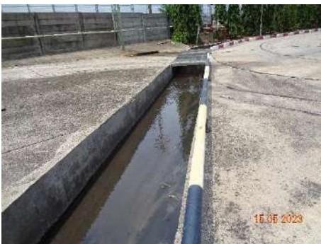
ภาพที่ 2.2-17 ร่องน้ำขนาดกว้าง 2 เมตร ลึก 1.5-2.2 เมตร ล้อมรอบกองถ่านหิน
