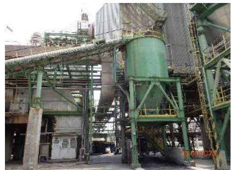
ภาพที่ 2.2-28 ไซโลหรือ Collecting Pit เก็บเล้าหนักแบบปิด
